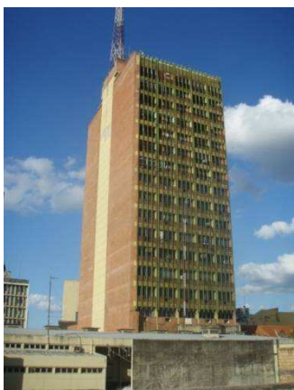
Les ouvertures sont exclusivement orientées vers le nord et sud sur ce bâtiment - Recife
