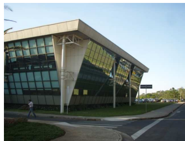
Ce bâtiment a une façade inclinée pour éviter l'ensoleillement direct - Belo Horizonte
