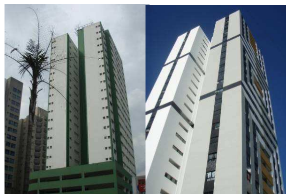
Ces tours cumulent une structure en H et une minimisation des ouvertures sur les façades ouest et est - Salvador et São Paulo
