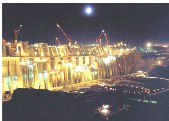
La construction de 7744m de long et de 196m de haut a offert un salaire à plus de 40 000 travailleurs
